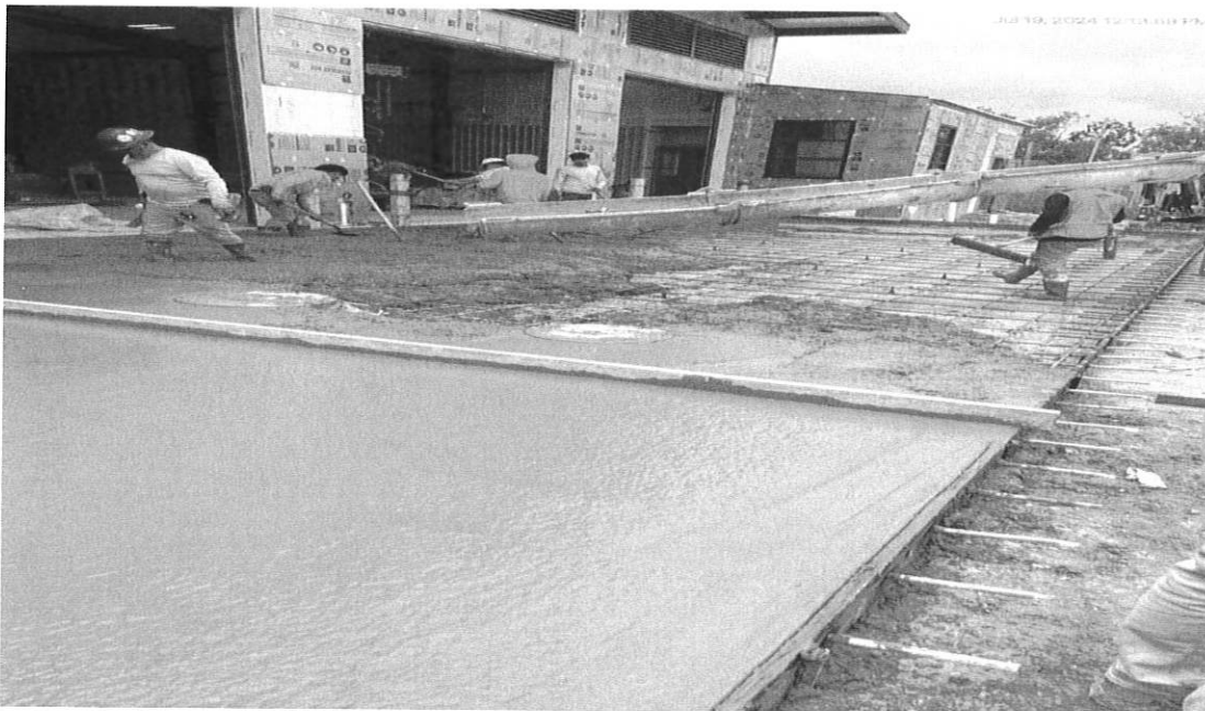
7/19/24 Paving pour underway
